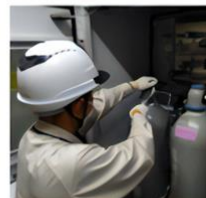
高純度ガス配管工事・ガス管理業務
